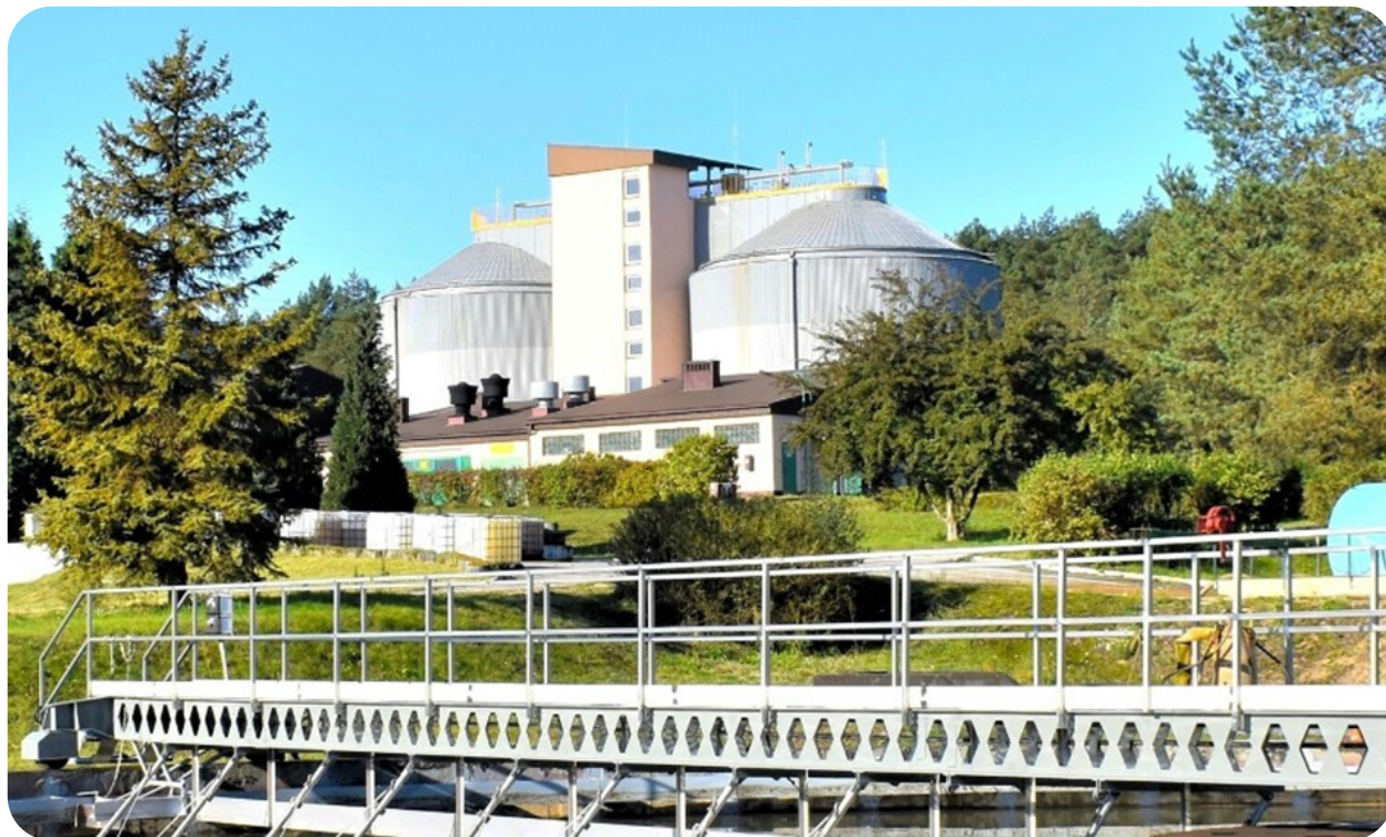
Biogazownia na terenie oczyszczalni ścieków w Chrzanowie (fot. Wodociągi Chrzanowskie)
