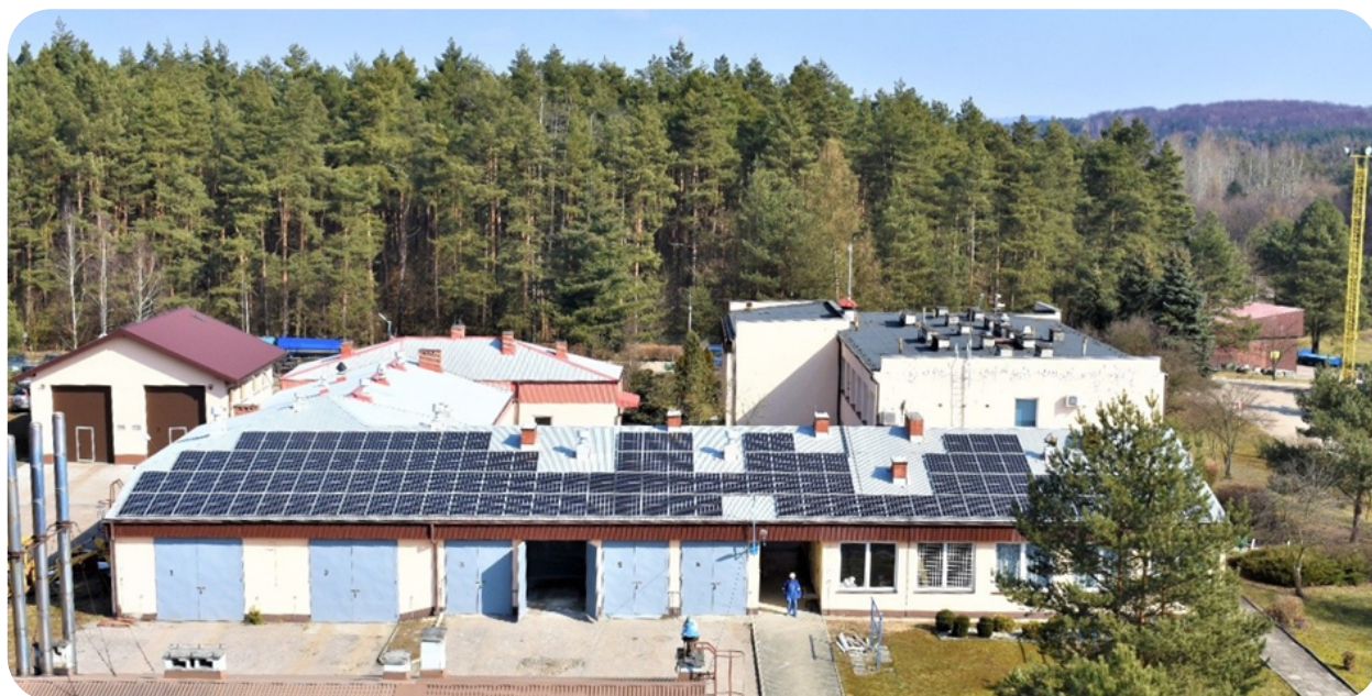
Instalacja fotowoltaiczna na dachu budynku gospodarczego oczyszczalni ścieków w Chrzanowie (fot. Wodociągi Chrzanowskie)
