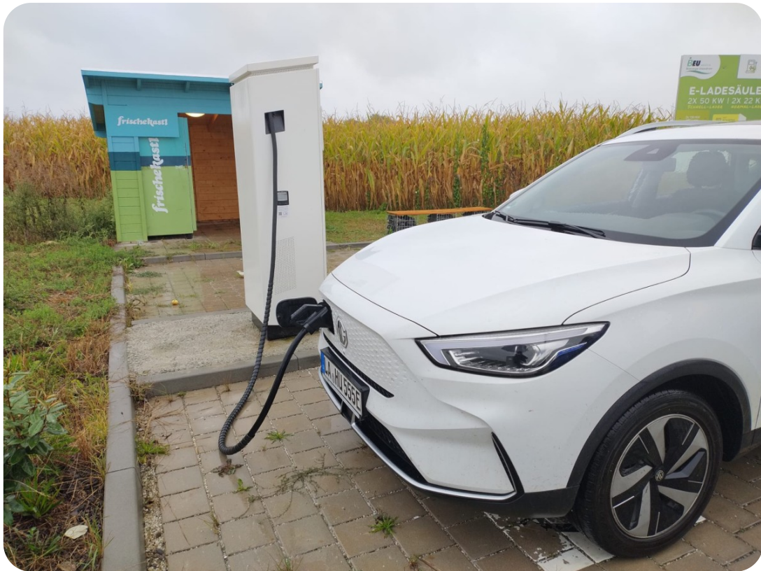
Stacja ładowania przy biogazowni
