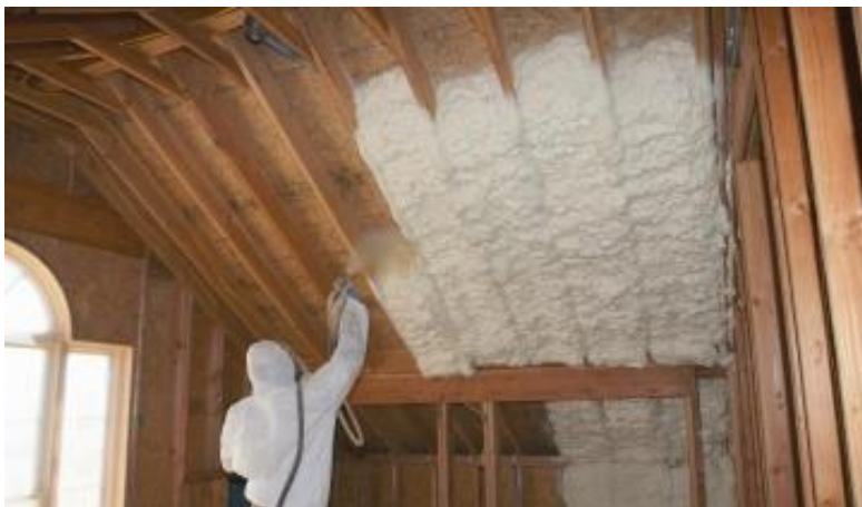
Rysunek 5 Metoda natryskowa pianą PIR/PUR. 17
