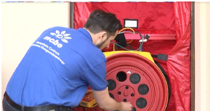
Rys. 6. Badanie szczelności obudowy budynku.
