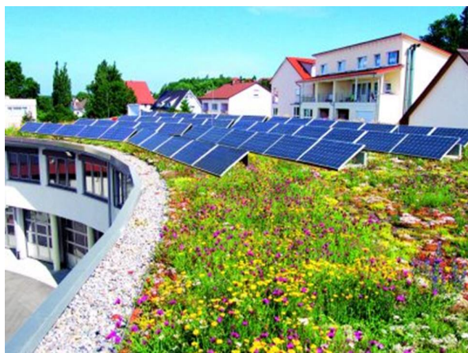
Rys.12 Przykład dachu zielonego 11
