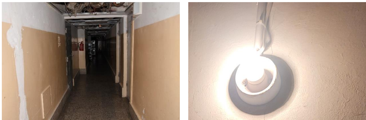
Rys. 16. Pomieszczenia podziemnych kondygnacji Teatru (źródło własne).
