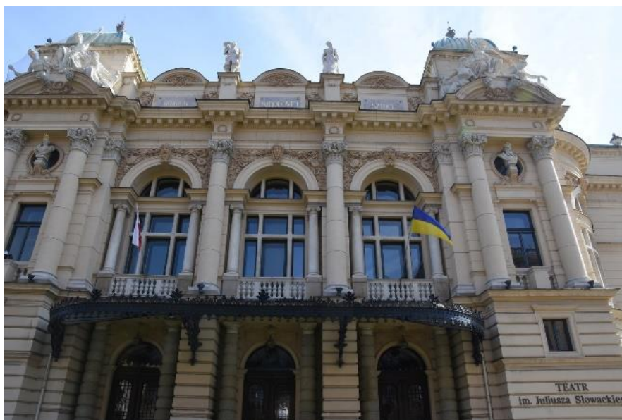
Rys. 11. Zachodnia elewacja budynku. Źródło własne autora.
