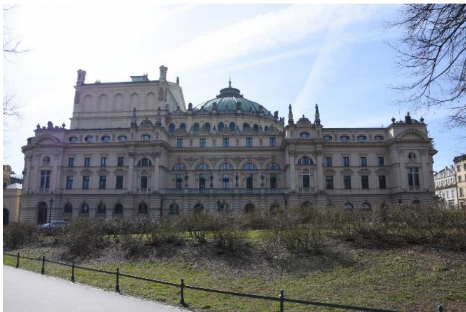
Rys. 12. Elewacja północna budynku teatru (źródło własne).
