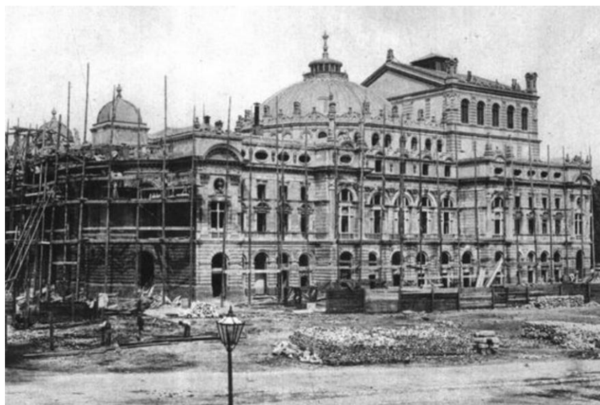
Rys 9. Fotografia z czasu budowy Teatru Słowackiego 8
