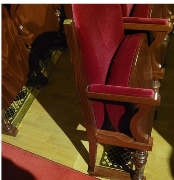
Rys. 18. Nawiewy i wywiewy z central wentylacyjnych (źródło własne)
