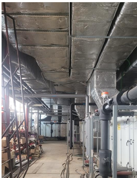
Rys. 17. Pomieszczenie techniczne. Centrale wentylacyjne (źródło własne)
