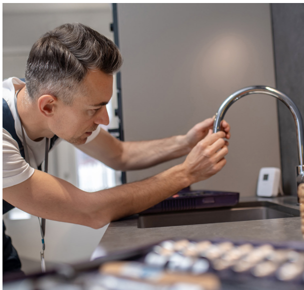
Zdjęcie 3: Montaż perlatora na baterii kranu
